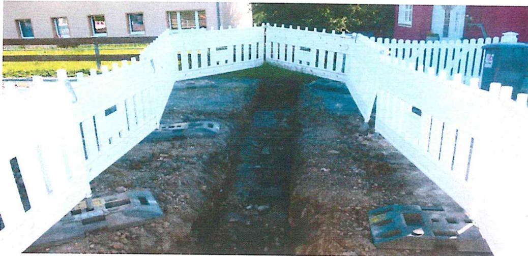
In der ersten Schürfung wurde festgestellt, dass sich im rechten Außenbereich unter den Asphalt-schichten Humusboden, mit Wurzel durchsetzt, befindet. Im übrigen Bereich wurde unter einer Packlage aus Gesteinsbrocken, die ein Seitenverhältnis von bis zu 20/20 cm aufwies, Lehm mit Steinen durchsetzt angetroffen.
